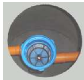
Blick durch die Einstiegsöffnung im Konus
