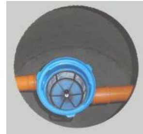
Blick durch die Einstiegsöffnung im Konus
