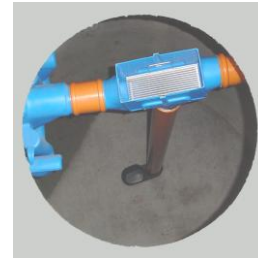
Blick durch die Einstiegsöffnung im Konus
