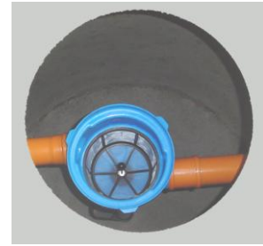
Blick durch die Einstiegsöffnung im Konus
